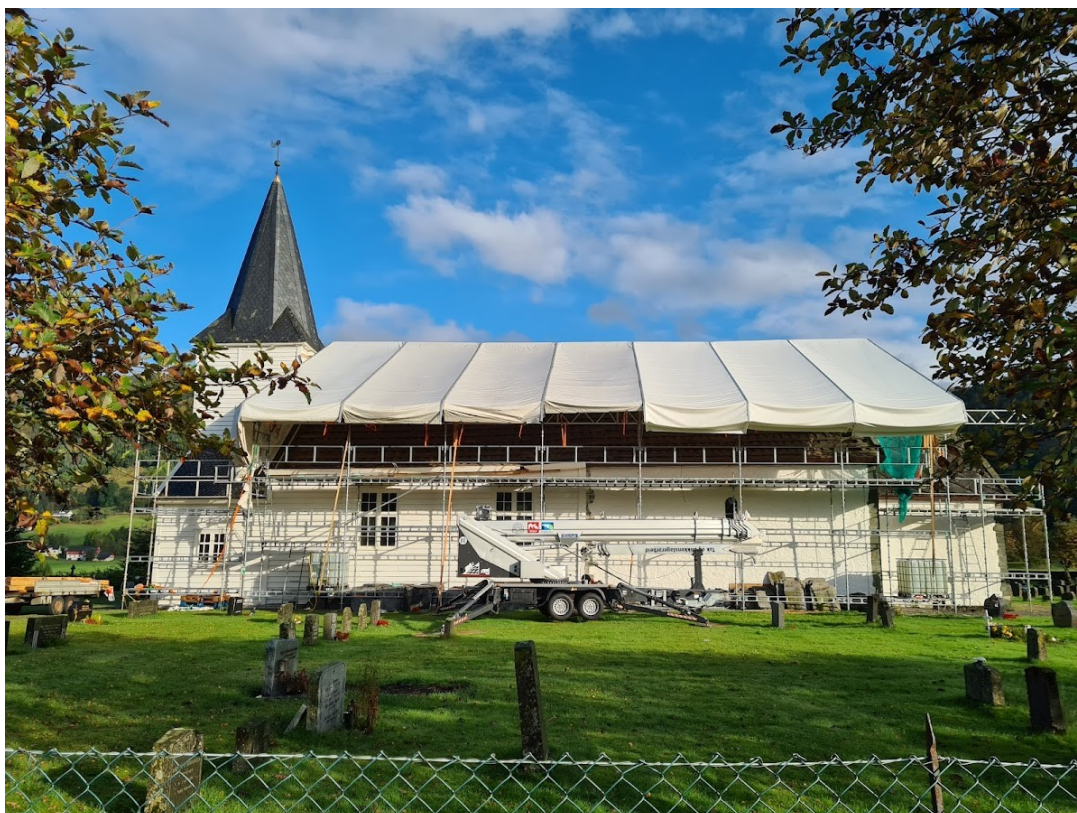
Istandsetting av taket på Stødle kyrkje.
